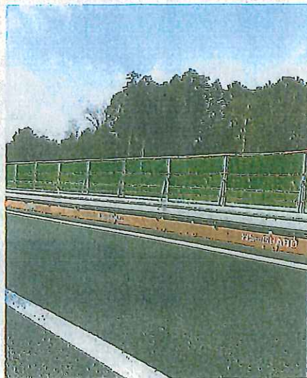
仮設ガードレール「HSGUARDDARD」
